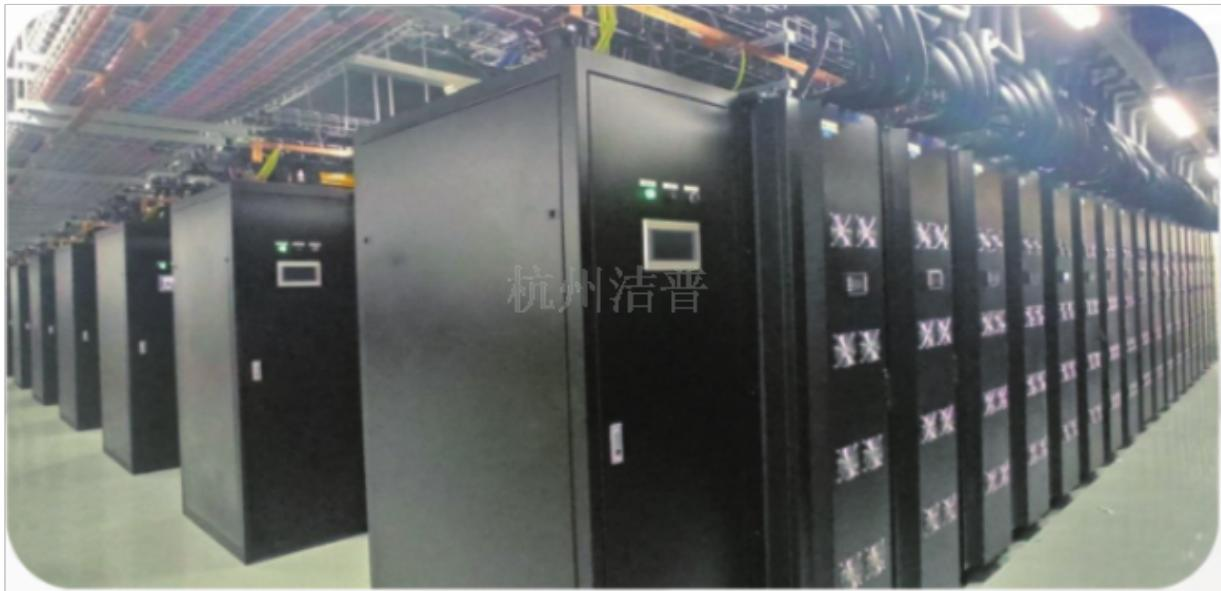
机房热管背板空调的出风温度一般是13℃-15℃，远远高于舒适空调的7℃-9℃的出风口温度。13℃-15℃的出风口温度高于22-24℃/湿度45%的空调运行环境下的温度。所以机房热管背板空调在这种情况下已经没有除湿的功能，热管背板空调所提供的冷量基本上用在降低温度上，所以热管背板空调的显热比高。而舒适空调的7℃-9℃的出风口温度，和24℃/湿度35%的空调运行环境下的温度差不多。所以在密闭的机房环境下，舒适空调在24℃/湿度35%的空调运行环境下仍然在除湿，降低机房环境中的湿度，增加了静电对机房设备的威胁。为了保证机房环境的湿度稳定，需要额外加湿，增加机房运行成本。
